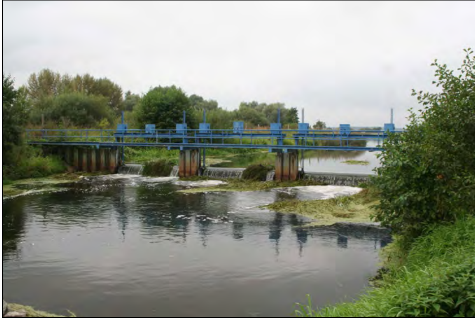
Abbildung 4: Ansicht Wehr Gladigau vom UW
