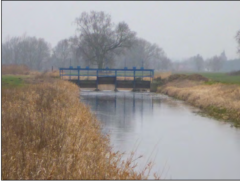
Abbildung 4: Ansicht Wehr Hagenau vom UW
