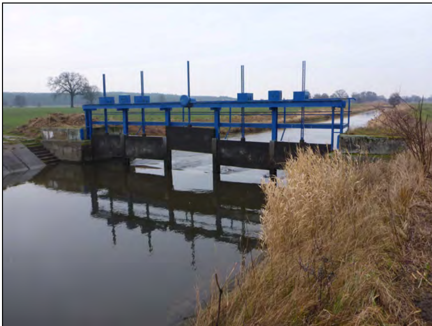
Abbildung 5: Ansicht Wehr Hagenau vom OW
