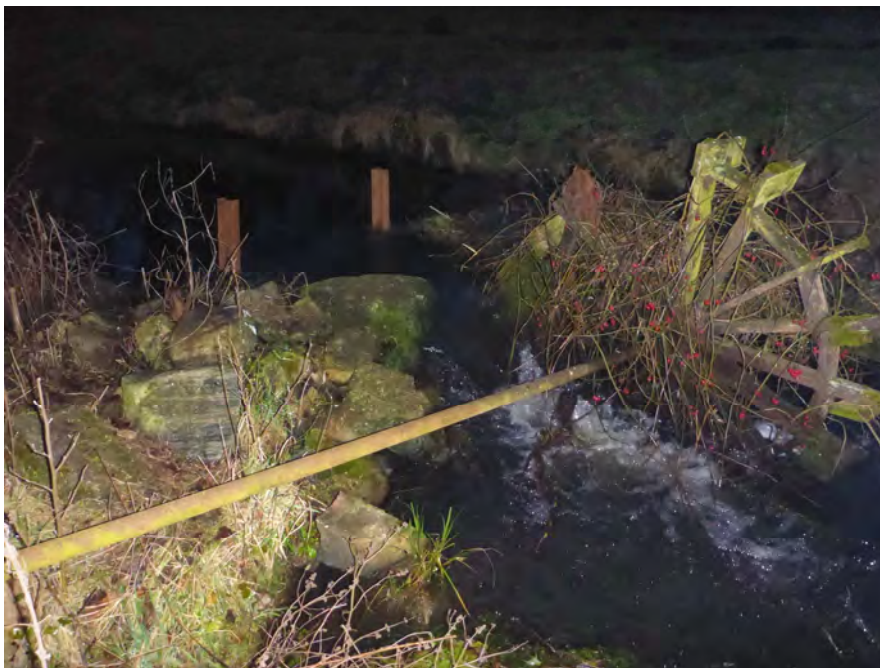
Abbildung 5: Ansicht Sohlabsturz vom UW
