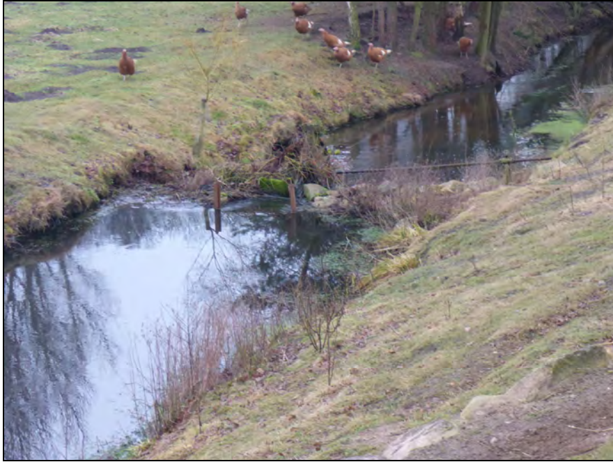
Abbildung 4: Ansicht Sohlabsturz vom Oberwasser
