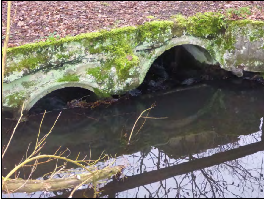
Abbildung 4: Ansicht Überfahrt vom Oberwasser
